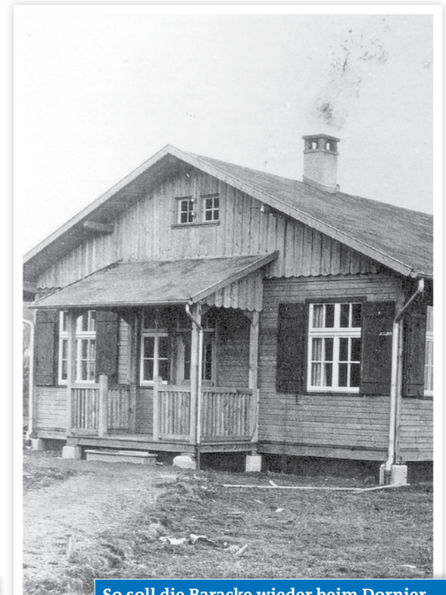
So soll die Baracke wieder beim Dornier Museum aufgebaut werden
